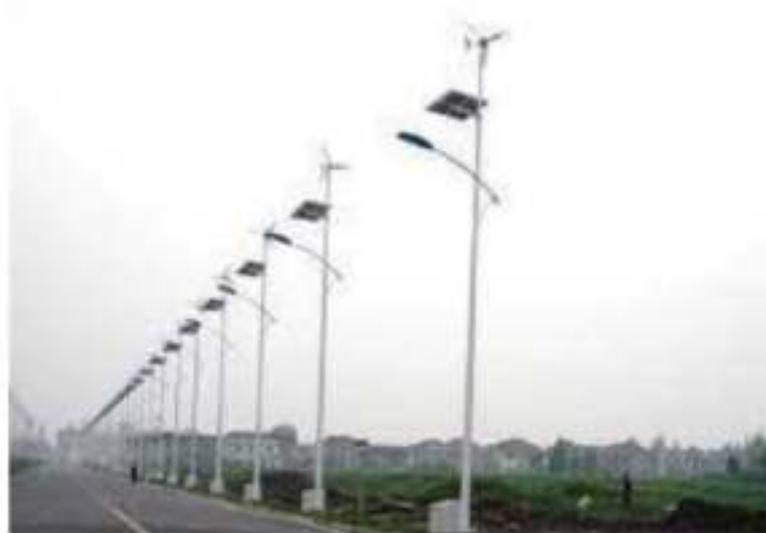
Pada gambar tersebut terlihat bahwa penerangan jalan dengan menggunakan tenaga surya dan tenaga angin. Perangkat ini juga dikontrol menggunakan smartphone dan menggunakan berbagai sensor untuk otomatisasi sistem yang digunakan.
